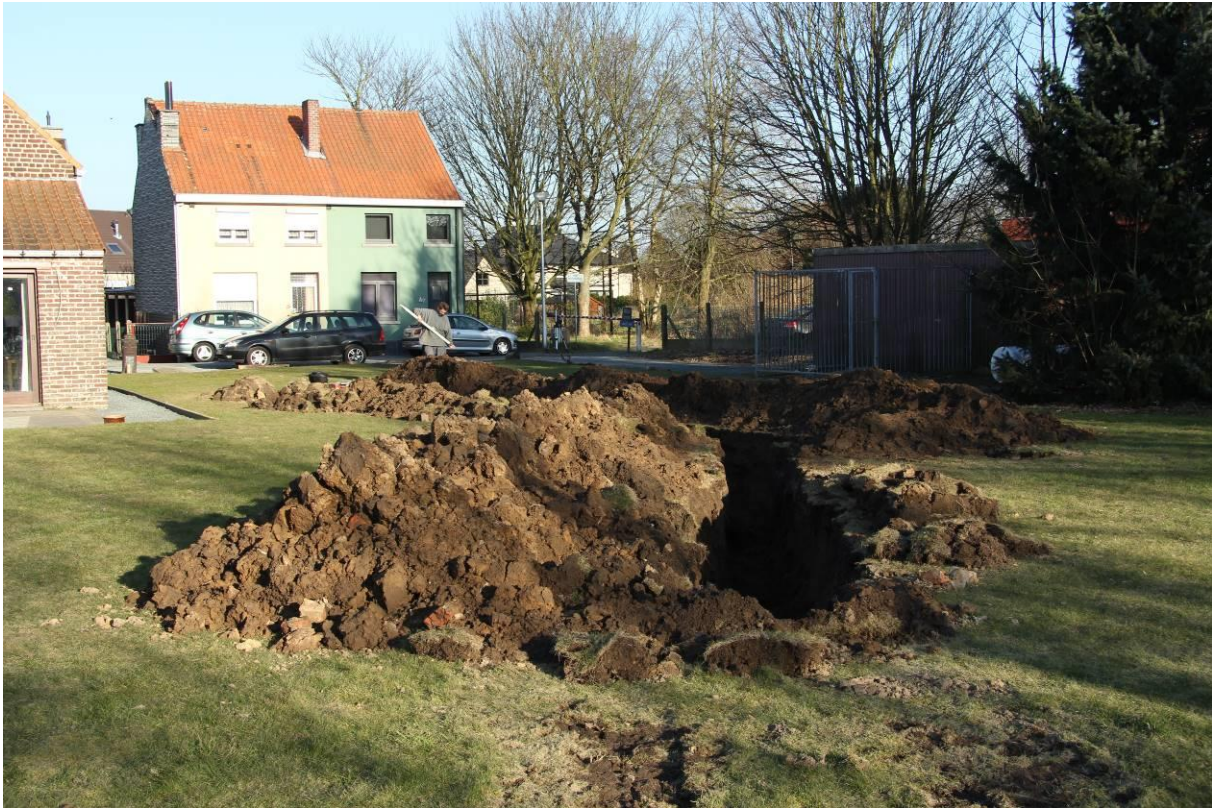
Fig. 5: Zicht op de sleuf vanuit het westen.
